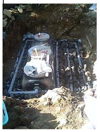
■ 有孔管を12m布設し、 管廻りに多孔質の溶 岩石・木炭を敷き詰 めて埋め戻し、接触 断面積を増やし好気 性菌の繁殖環境を整 えた。
